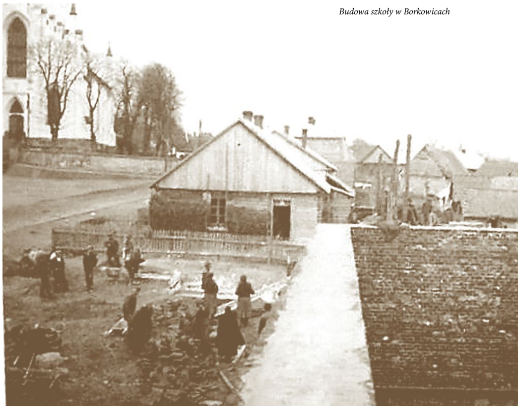
Budowa szkoły w Borkowicach
